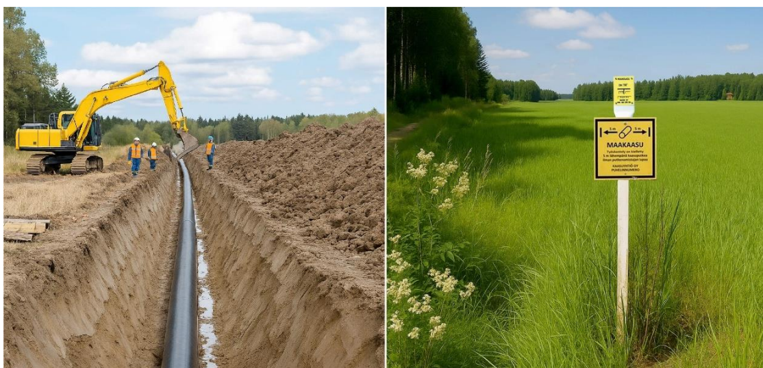
Kuva 3-7. Putkikaivanto ja putken lasku pellolla, sekä pelto asennus- ja viimeistelytöiden jälkeen seuraavana vuonna kuvattuna.
